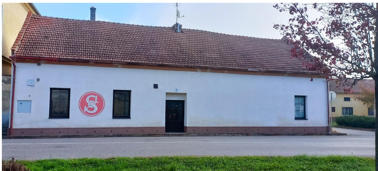
Obr. 22: Budova TJ Sokol v Topolanech Zdroj: ENVIPARTNER, s.r.o. (2024)
