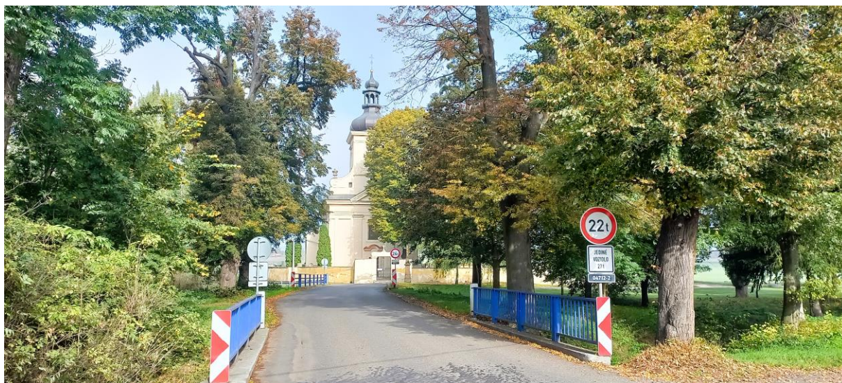
Obr. 29: Most přes řeku Haná v Topolanech Zdroj: ENVIPARTNER, s.r.o. (2024)
